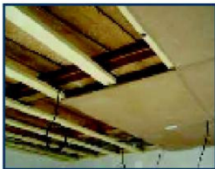
Colocação por baixo de um pavimento
