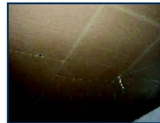
Aspecto final depois de aplicadas as placas de ONDUPHONE WELL
