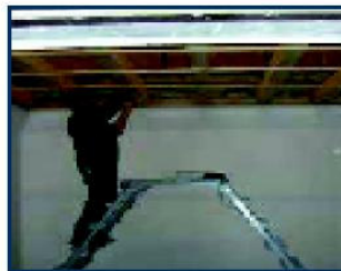
Placas ONDUPHONE WELL aparafusadas a ripas de madeira
